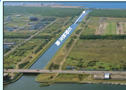
石狩放水路 (S57年完成)
