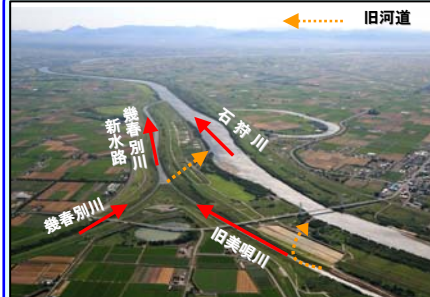
幾春別川新水路 (H18年完成)
