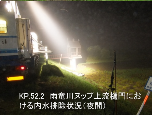
KP.52.2 雨竜川ヌップ上流樋門における内水排除状況
