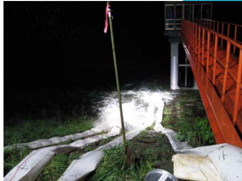
排水ポンプ稼働状況(夜間作業)
