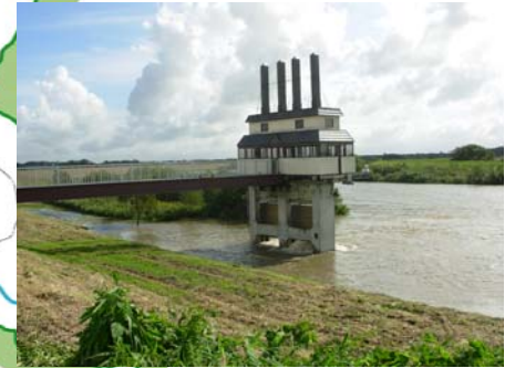
排水機場稼働状況
