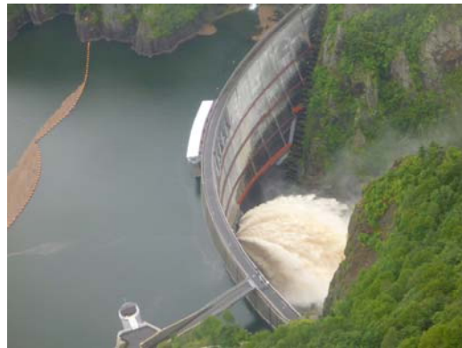
防災操作中の豊平峡ダム
