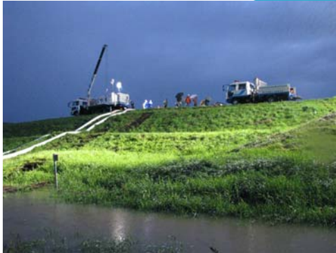
排水ポンプ稼働状況
