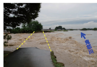
被災状況(拡大写真)
