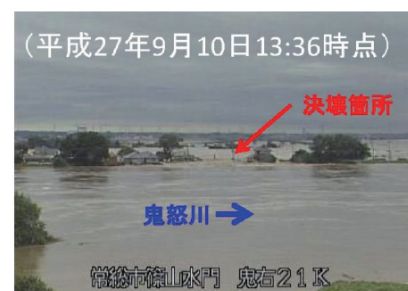
被災状況(対岸より撮影)
