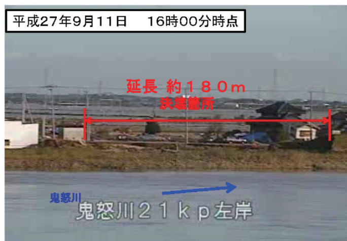
被災状況(対岸より)
