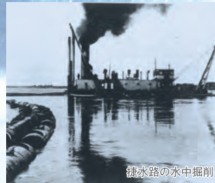
樋水路の水中掘削
