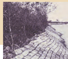
コンクリート単床ブロックによる護岸
