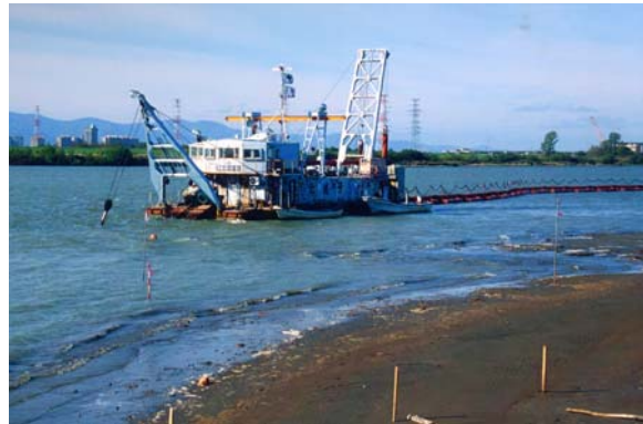
浚渫作業風景
