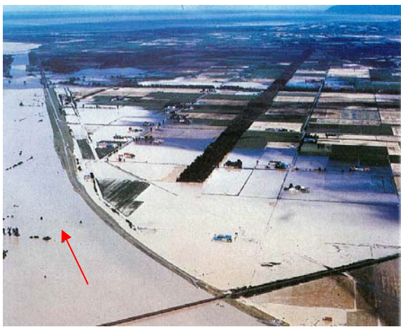
石狩川右岸 美登位上流築堤篠津 鉄道橋下流の氾濫状況(江別市)
