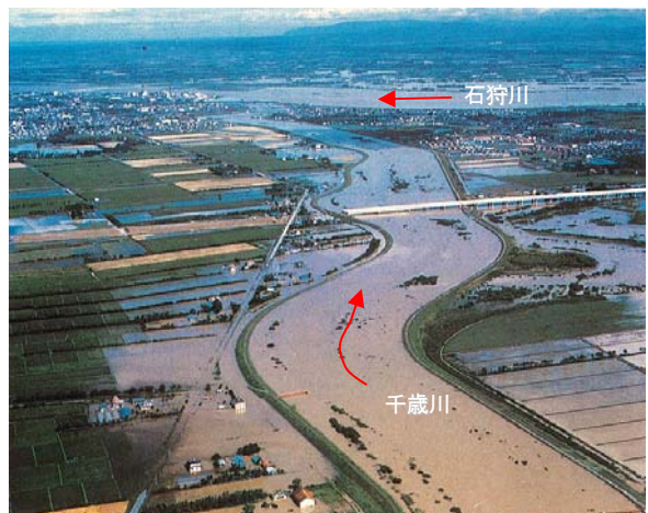
石狩川左岸 千歳川合流点付近 東野幌の氾濫状況(江別市)
