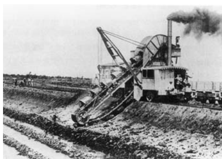
捷水路の陸上掘削 (ラダーエクスキャベーター)
