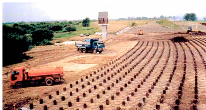
軟弱地盤地帯の堤防基盤処理状況 (パイルネット工法)
