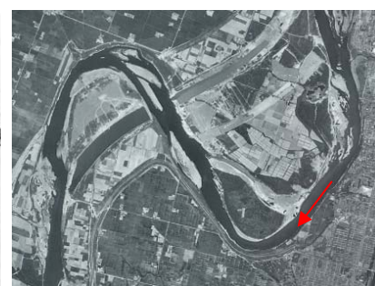
工事中の砂川捷水路(S43)
