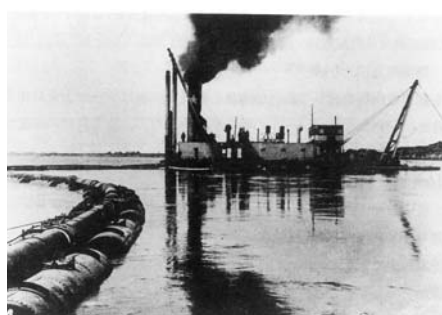
捷水路の水中掘削(ポンプ船)
