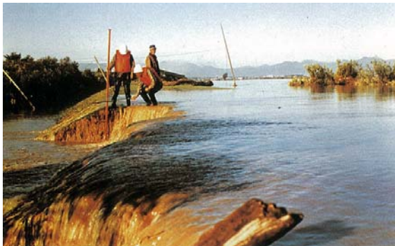
石狩川左岸 豊幌築堤越水氾濫(江別市)
