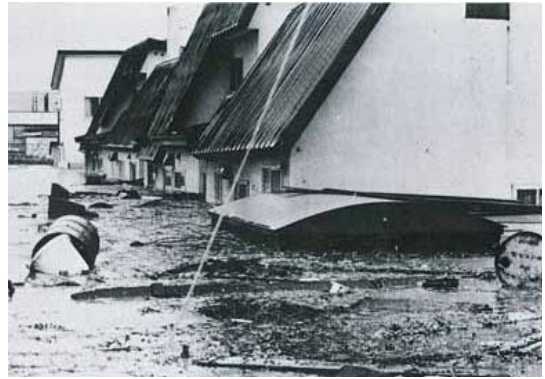
石狩川左岸 市街地の床上浸水状況(江別市)
