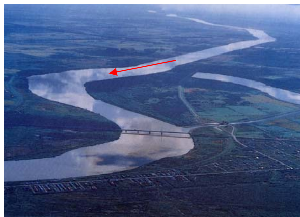
土木遺産 (出典：捷水路) (石狩川～生振捷水路)
