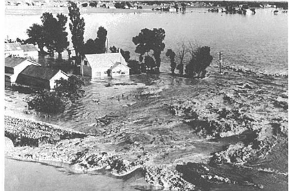
石狩川左岸 大曲左岸築堤の越水破堤状況(美唄市)
