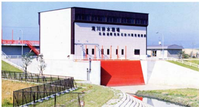
滝川排水機場(昭和 53 年完成)
