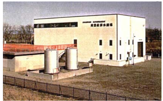
美登位排水機場(昭和 62 年完成)
