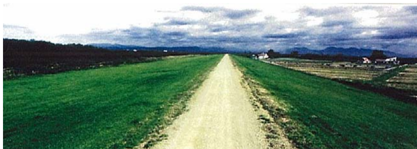
軟弱地盤地帯における緩傾斜堤防(丘陵堤)
