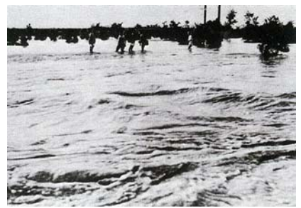
石狩川左岸 濁流にさらされ る国道 12 号 (江別市豊幌)
