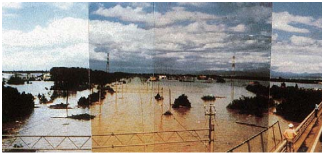
石狩川左岸 豊幌地区氾濫状況 国鉄函館本線・国道12号冠水交通不通(江別市)
