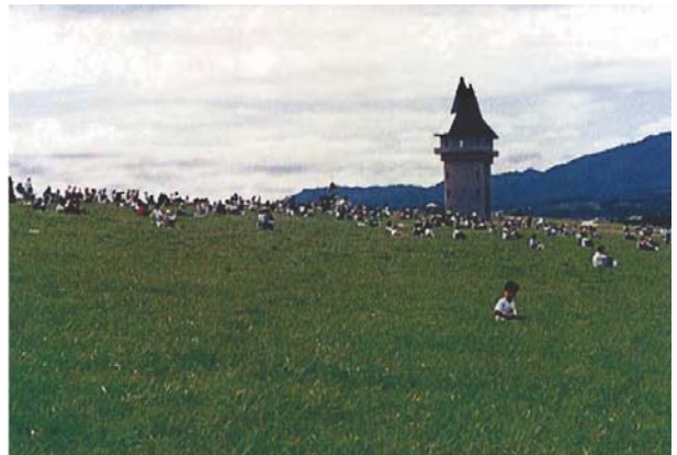
砂川築堤／丘陵堤（砂川市）
