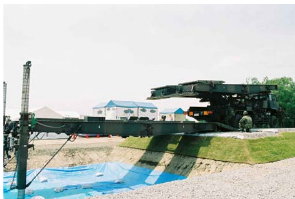
仮設橋設置訓練
