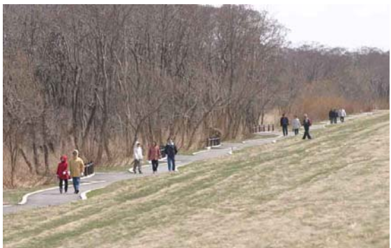
生振築堤（石狩市）
