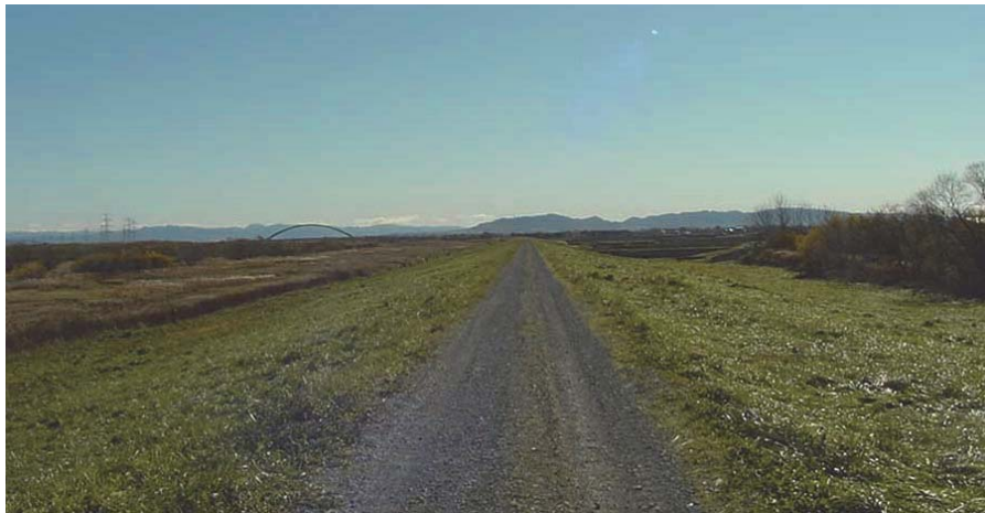
夕張川の緩傾斜堤防
