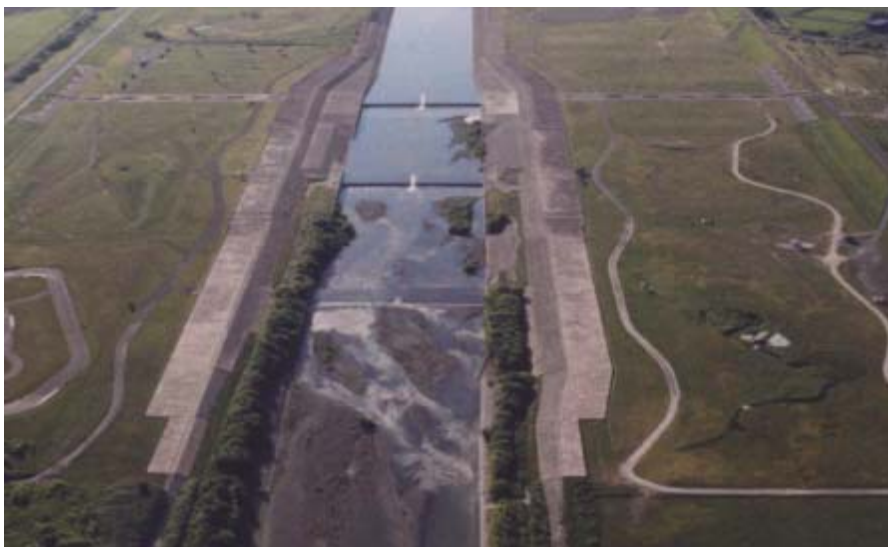
清幌床止（平成 4 年完成）
