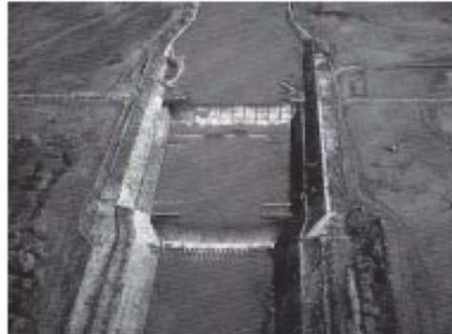
清幌床止（昭和16年完成）
