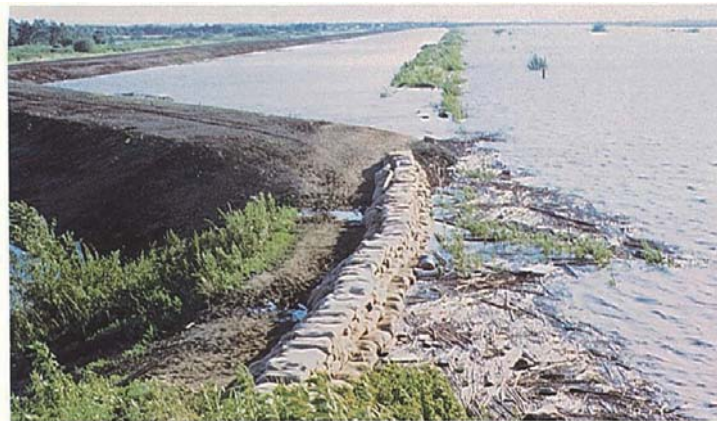
土のうを積んで越水を防ぐ (幌向川左岸西1号橋下流地先、昭和50年8月洪水)
