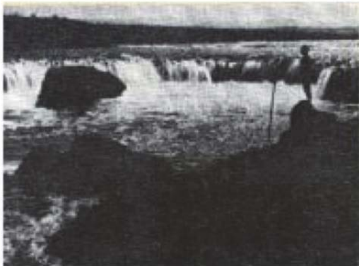
河床の洗掘が著しく、ナイヤガラの滝のように流れる清幌床止の下流 (昭和12年6月)
