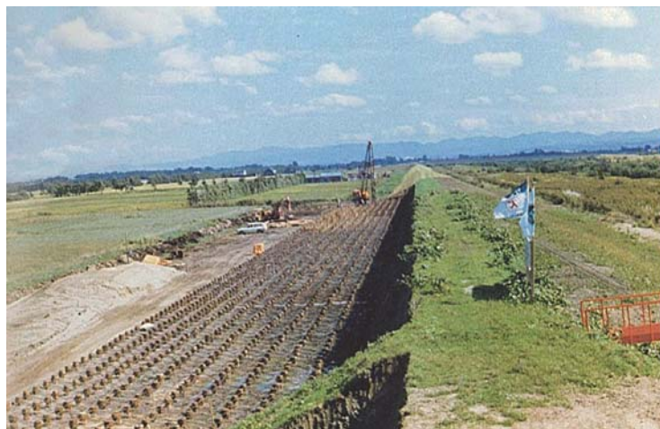
軟弱地盤地帯の堤防基盤処理状況 (パイルネット工法、幌向川右岸築堤)
