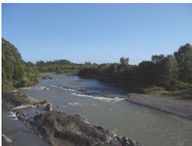
多良津橋付近の露岩河床
