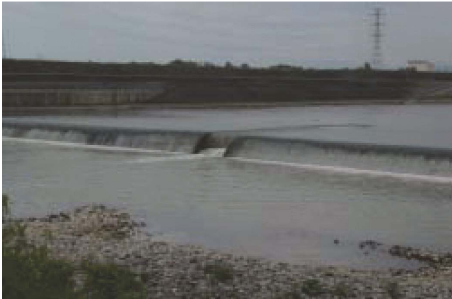
清幌床止の魚道
