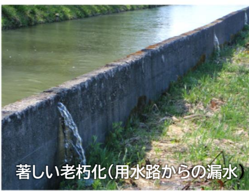
【農業水利施設(用水路)の整備】
