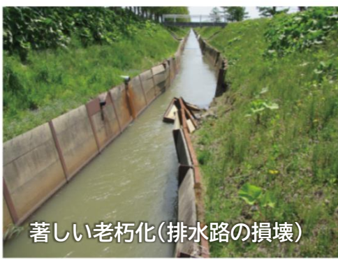
【農業水利施設(排水路)の整備】
