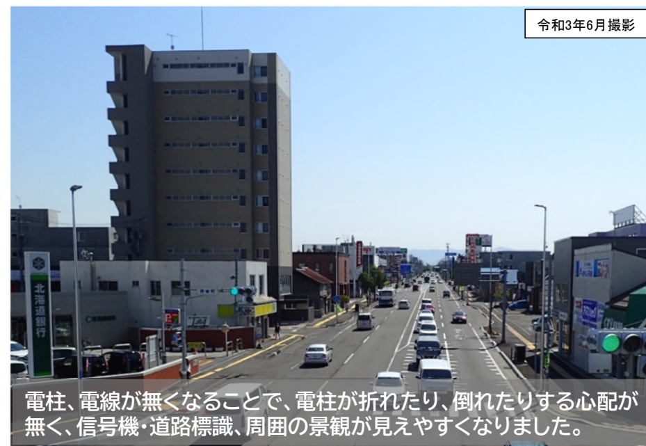
【整備後】(国道12号江別市野幌町)
