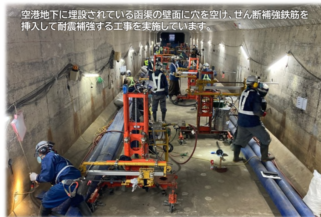
【美沢川函渠耐震補強 施工状況】
