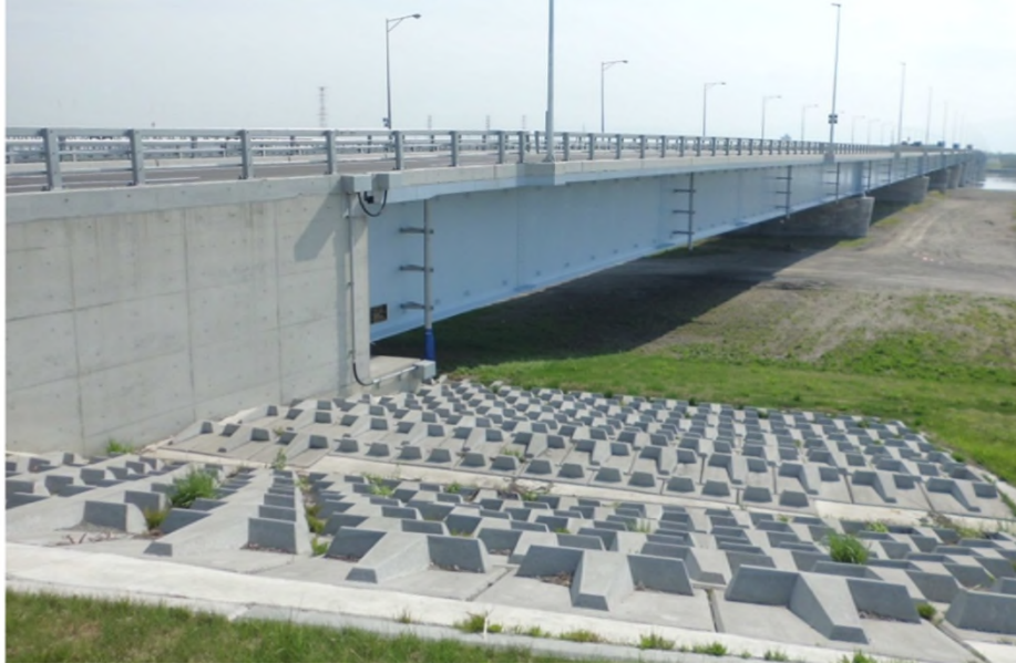
【道路構造物の流失防止対策(橋台の護岸整備)】
