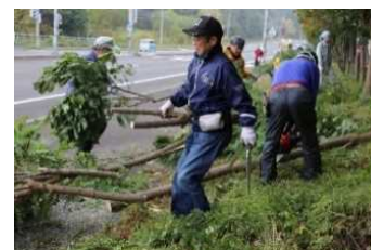
樹木伐採している様子
