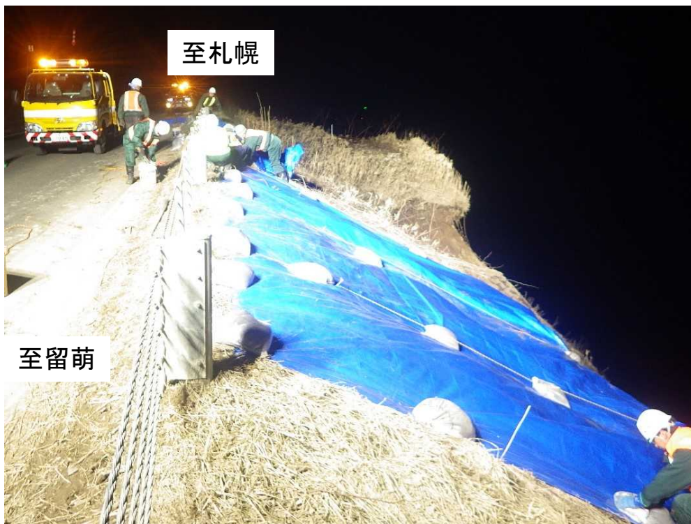
応急対策作業状況
