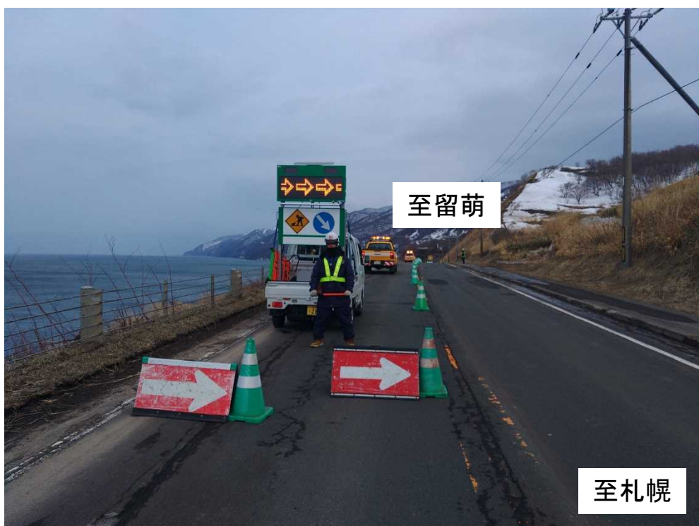
現地状況(片側交互規制)
