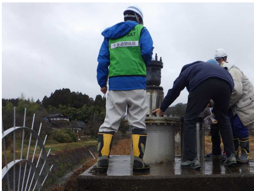
充水確認の状況
