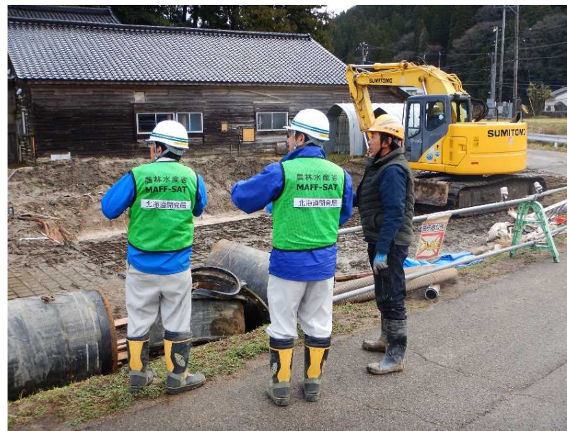
応急復旧工事現地打ち合わせ
