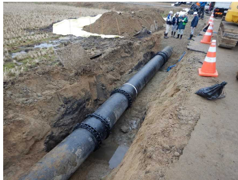
応急復旧状況確認
