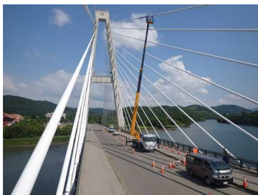
橋梁補修（斜材保護カバー補修）
