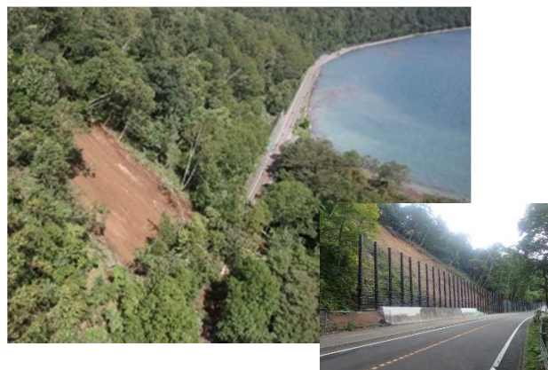
道路斜面对策（被災状況と土砂防護柵設置後）
