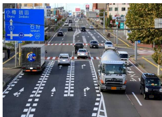
【事故対策後】国道5号手稲駅前通交差点 (右折車線の設置、滑り止め舗装、減速路面標示等を実施)
