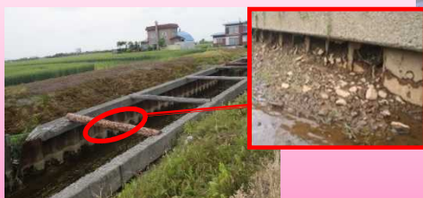
排水路の傾倒(倒壊寸前)
