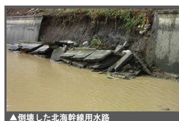
▲倒壊した北海幹線用水路
