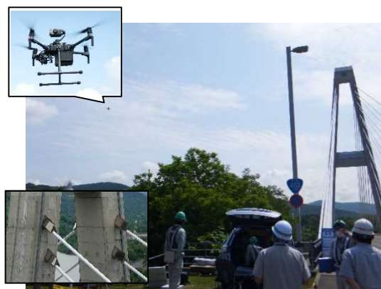
ドローンによる橋梁点検状況 (国道452号 芦別市)
