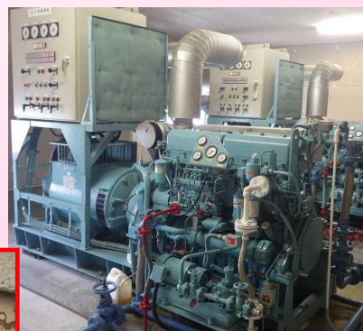
機械設備の老朽化 (自家発電設備)
