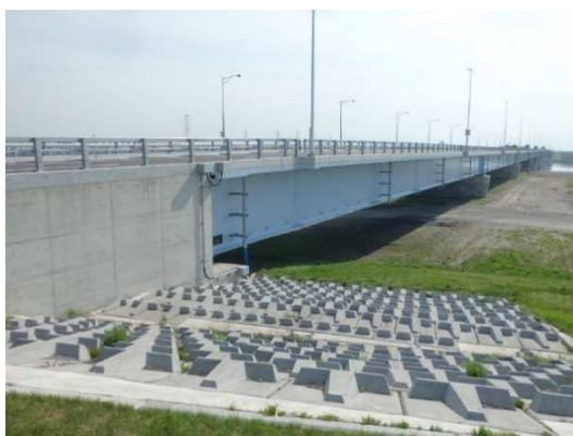
橋梁の流失防止対策（橋台の護岸整備）
