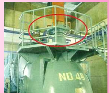
排水機ポンプ軸封部からの漏水 (運転停止の発生)
