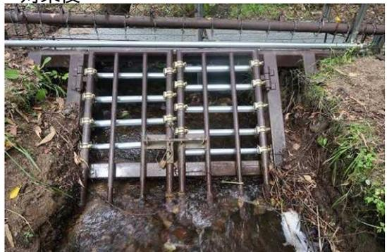
※単管パイプを15cm以下の間隔で設置
