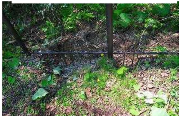
侵入防止対策作業状況（鉄筋打ち込み）
