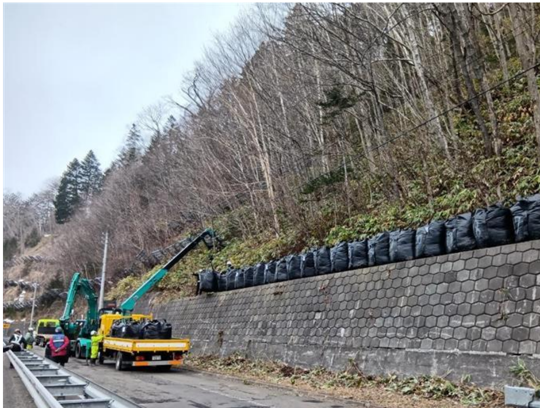
土嚢設置状況
