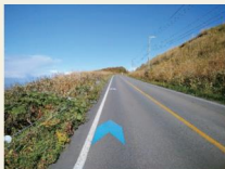
急カーブ手前
