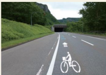
トンネル手前
