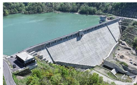
新桂沢ダム (令和6年3月完成)
