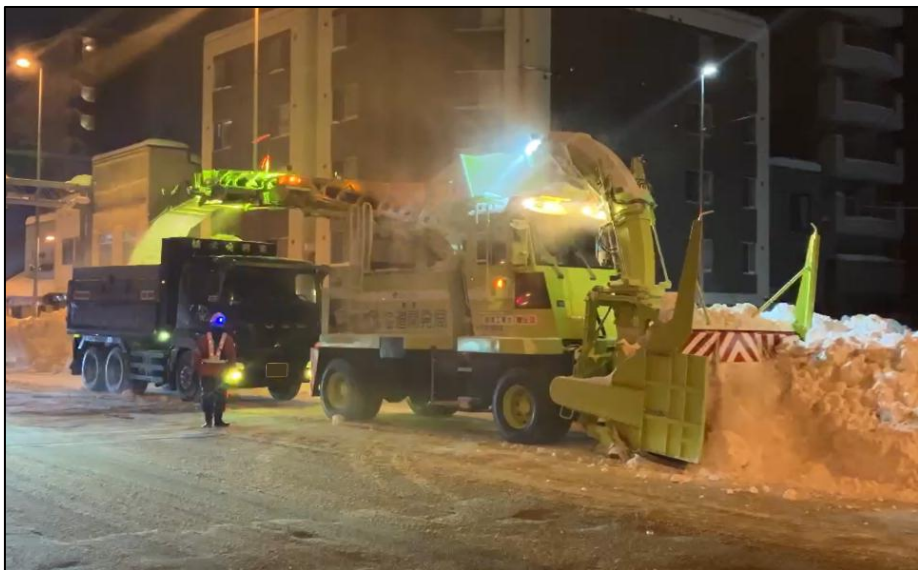
国道の拡幅除排雪状況
