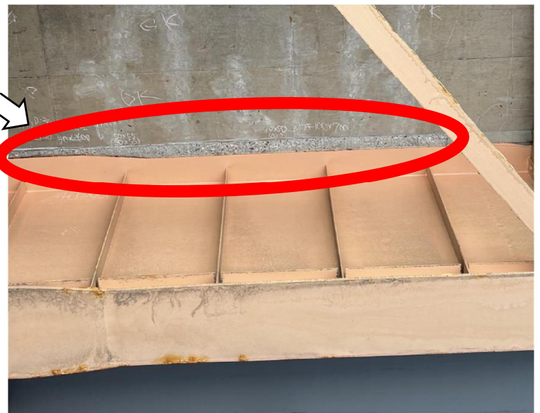
コンクリート片剥離箇所
