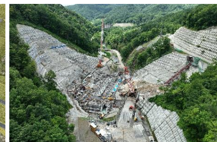
三笠ぽんべつダム (工事中の写真)
