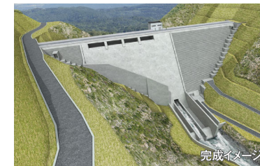
Mikasa ponsersu dam 三笠ぽんべつダム【建設中】 奔別川に新たに建設する三笠ぽん べつダム。普段は水をそのまま流下 させ、洪水時のみ一時的に流水を貯 留する流水型ダムとして流域の安全 を守ります。
