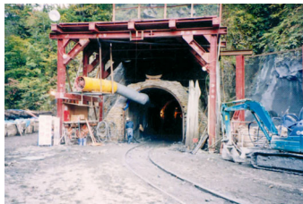
三笠ぽんべつダム仮排水路トンネル工事 (H13年)
