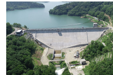
Shin katsurazawa dam 新桂沢ダム【R6年度管理移行】 旧桂沢ダムを嵩上げ(約1.2倍)、 ダムの機能を強化する新桂沢ダム。 総貯水容量はこれまでの約1.6倍 となり、治水・利水両面で流域の暮 らしを支えます。
