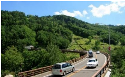
札幌シーニックバイウェイ藻岩山麓・定山溪ルート (国道230号札幌市南区定山溪国有林L=10km)
