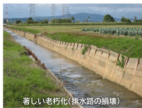
【農業水利施設(排水路)の整備】 国営かんがい排水事業篠津運河下流地区
