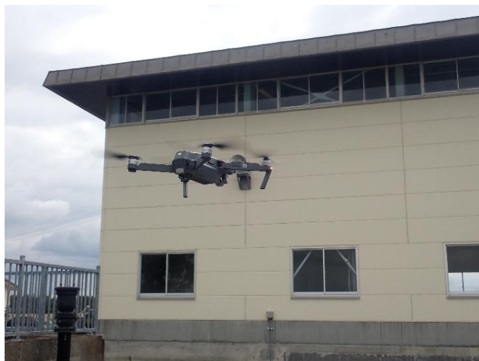
ドローンを活用した 揚水機場（南幌町）の機能診断
