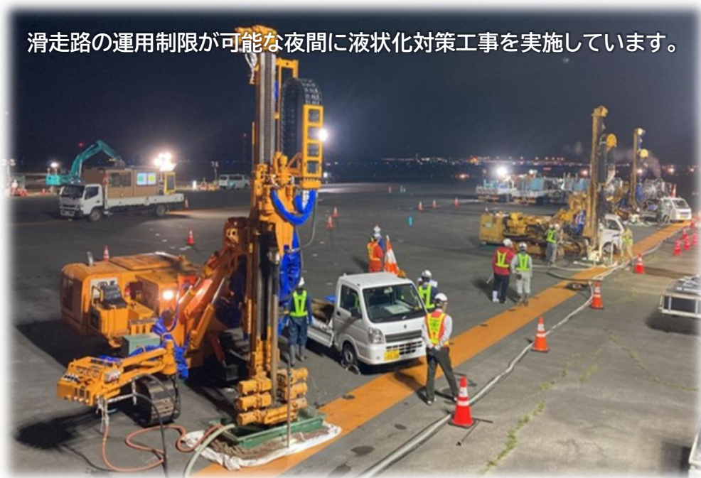
【滑走路液状化対策 施工状況】
