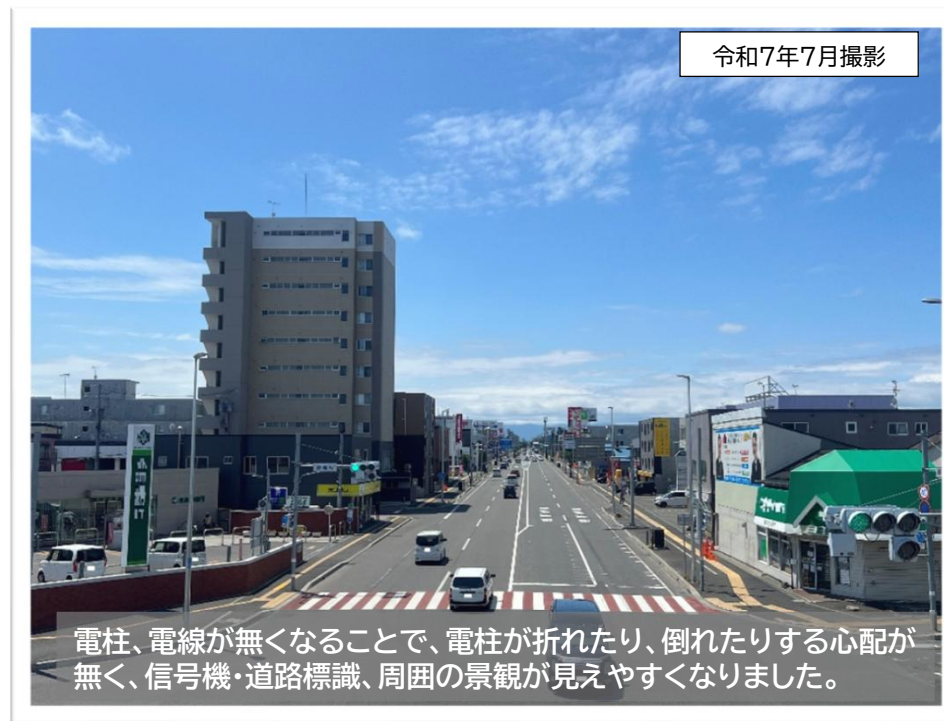
【整備後】(国道12号江別市野幌町)
