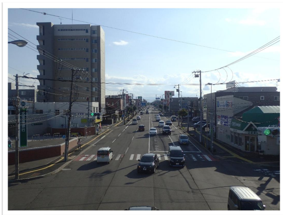
【整備前】(国道12号江別市野幌町)
