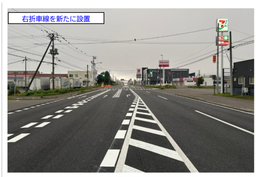
交差点における交通安全対策(国道12号 砂川市)
