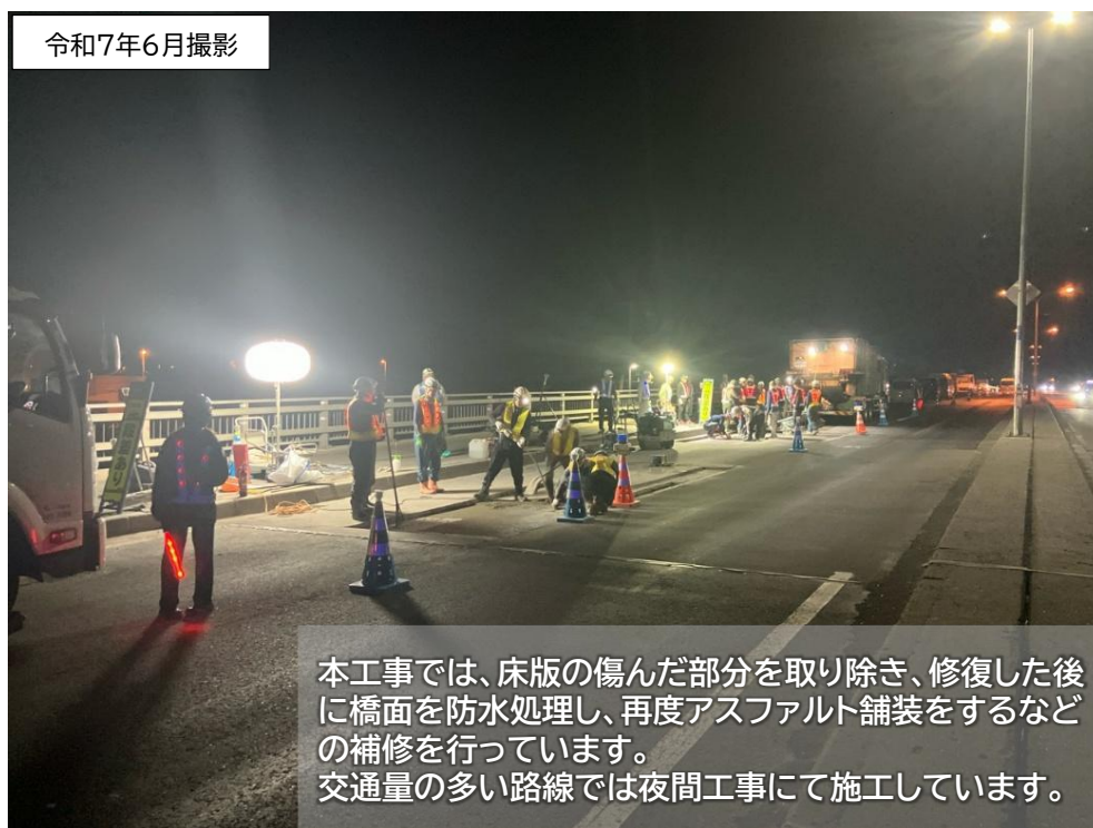
【国道275号 雁来大橋の橋梁補修(札幌市)】
