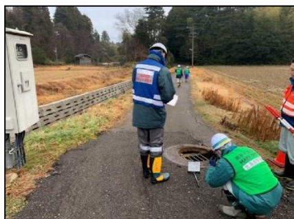
【農業集落排水施設の調査】
