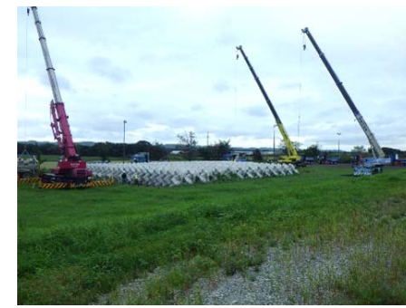
根固めブロック搬出
