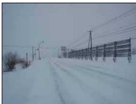
防雪柵の整備
