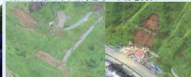
道道元地香深線被災状況
