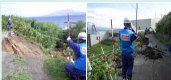
礼文小学校箇所被災状況調査
