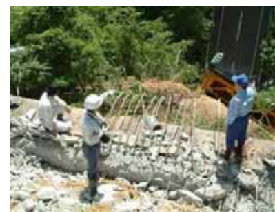
被災状況調査(現地調査)
