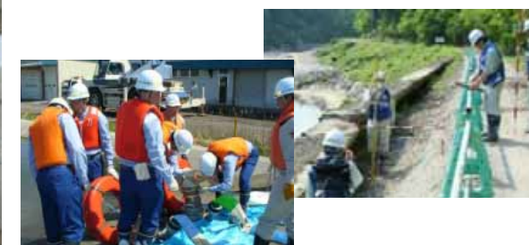
訓練:排水ポンプ設置訓練、実地訓練などによる平時の備え
