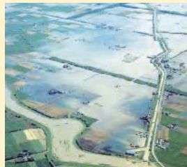
旧夕張川・馬追運河合流点付近の避難状況 (昭和56年8月上旬洪水)
