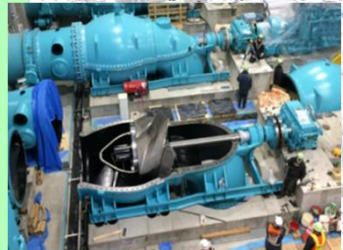
排水機場ポンプ設備の整備（イメージ）
