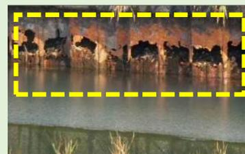
鋼矢板護岸の腐食による開孔
