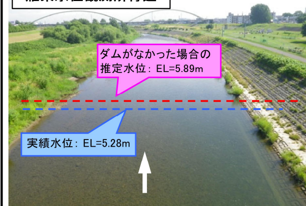
雁来水位観測所付近
