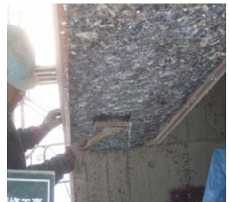
写真-15 プライマー塗布
