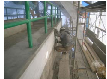
写真-17 下地処理
