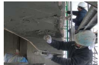
写真-16 断面修復
