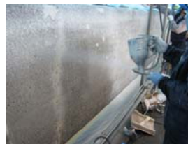
①下塗り施工 (吹付け)
