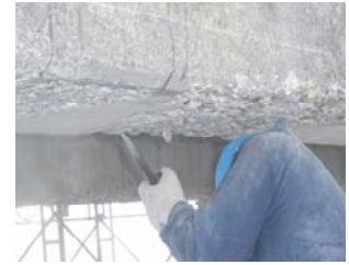
写真-14 下地処理
