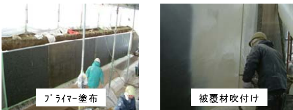
写真-5 樹脂系補修工法の施工状況
