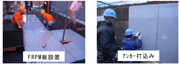
写真-6 パネル系補修工法の施工状況
