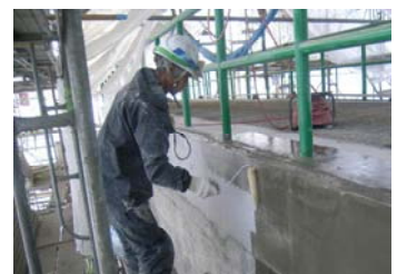
写真-18 プライマー塗布
