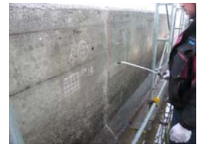
②噴霧器で散水養生
