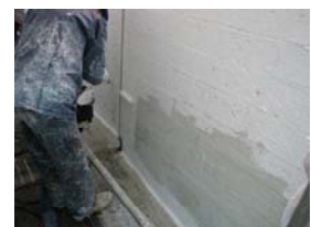
②仕上施工 (ローラー)
