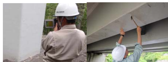
サーモグラフィ調査
