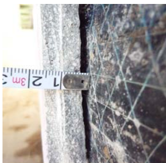
写真-5 浮き高さの確認
