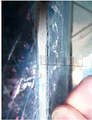
写真-10 シートの剥離状況
