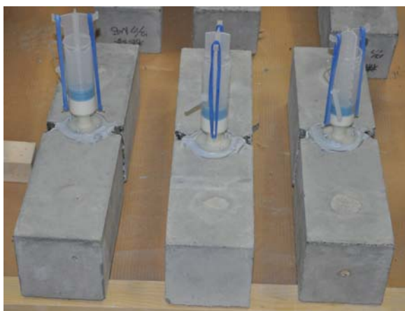
写真-3.1 自動式低圧注入工法による注入状況
