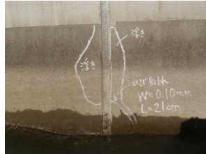
写真-12 右岸擁壁側壁
