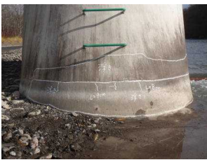
写真-13 P2堰柱
