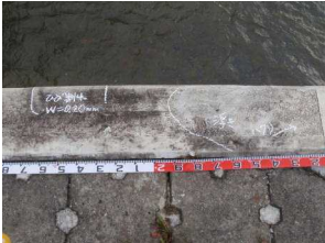
写真-11 右岸擁壁天端
