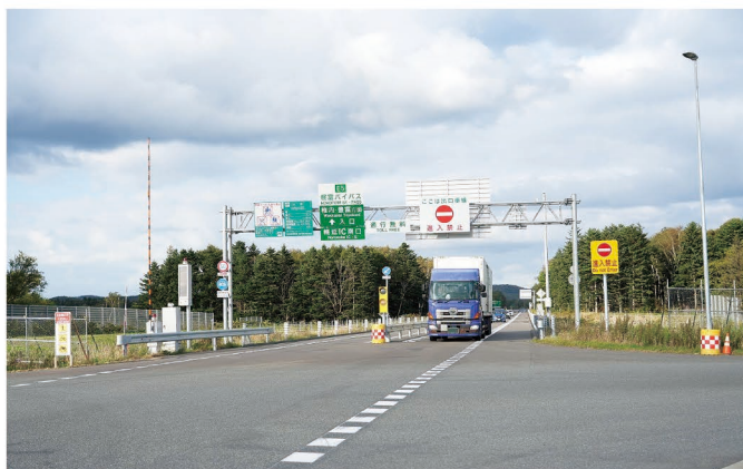
天塩防災の開通(幌延町:延長1.8km)
