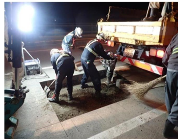
補修状況：国道12号（札幌市）
