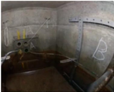
マンホール内写真
