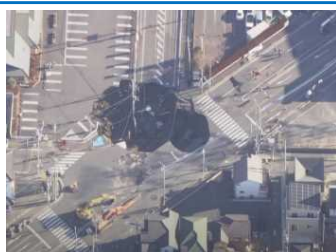
1月31日時点の事故現場の状況
