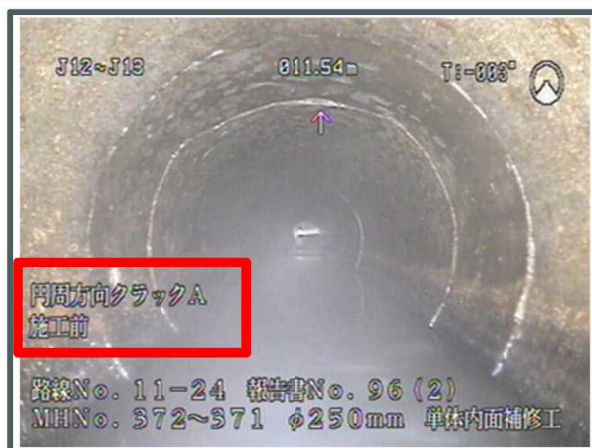
TVカメラによる管内の詳細調査
