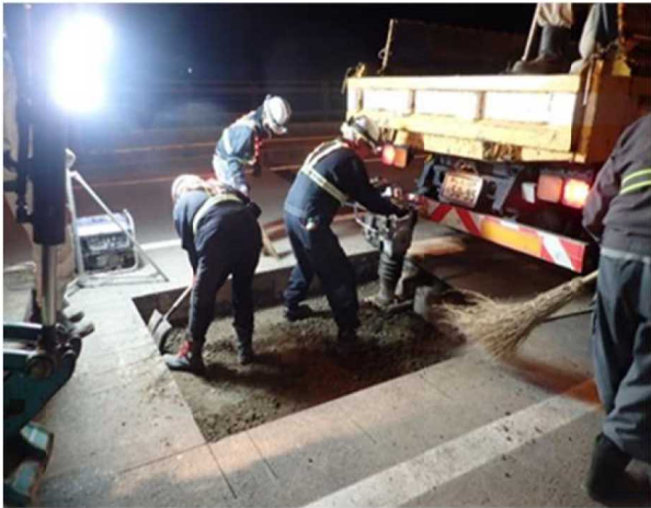
補修状況：国道12号（北海道札幌市）
