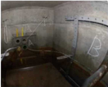
マンホール内写真
