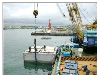
係船柱用ケーソン整備状況
