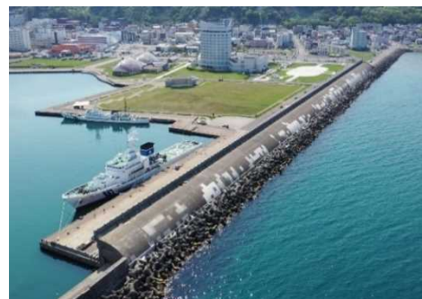
北防波堤ドーム全景
