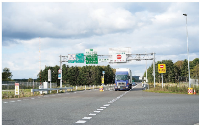
天塩防災の開通(幌延町：延長1.8km)
