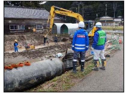
【復旧工事の状況】
