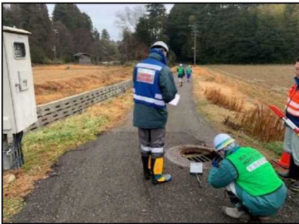
【農業集落排水施設の調査】
