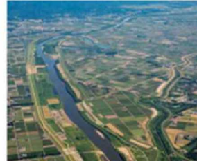
▼ 流域治水の推進 (石狩川と施工中の北村親水地)
