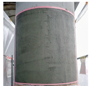
目視での確認が困難な柱表面の劣化は、柱の凹凸(微地形)をレーザー計測し、凹凸を図化することで確認しています
