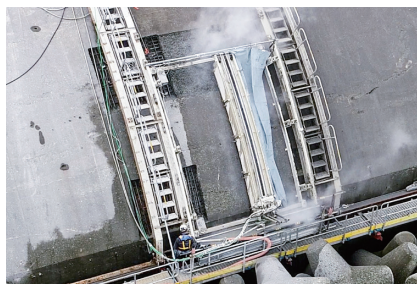
機械式のウォータージェットによる自動掘削(ロボット施工)により、効率化と共に安全・安心な施工を行っています
