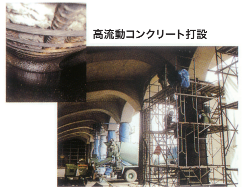
PC鋼より線巻付け完了
