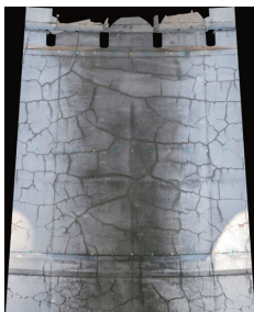
ドローンによる高解像度写真から柱のひび割れを展開図に整理し、今後の維持管理の記録として保存しています
