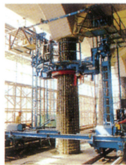
PC鋼より線巻付け
