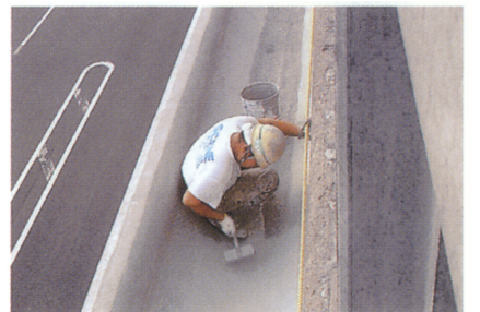
防水剤塗布(1層目縦方向)
