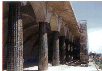
PC鋼より線巻付け完了
