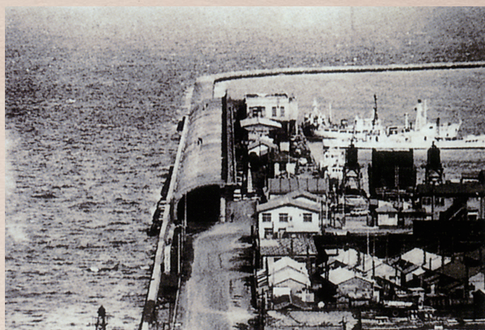
北防波堤ドーム全景(昭和40年頃撮影)
