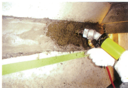
修復材吹付け(ハンディショット)
