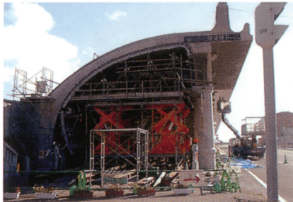
天蓋部施工状況
