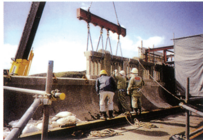
既設高欄撤去状況
