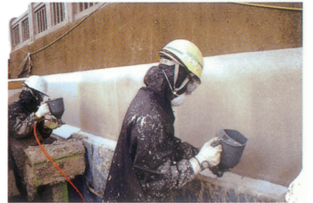
仕上げ(カラーサンド吹付け)
