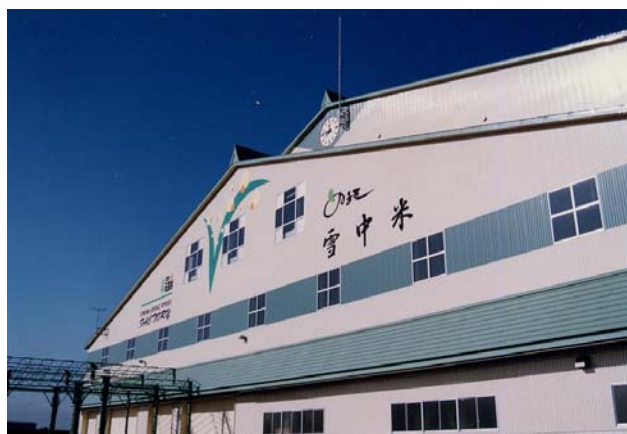
スノークールライスファクトリー (米貯蔵に雪を活用した施設)
