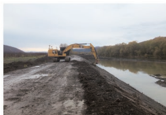
河道掘削状況（渚滑川）
