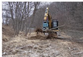
樹木伐採状況（常呂川）
