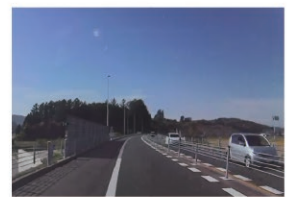
E61 十勝オホーツク自動車道ワイヤロープ設置状況
