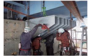
国道39号 美幌大橋耐震補強
