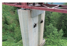
国道39号 橋梁点検
