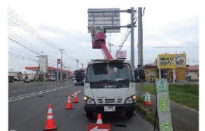
国道39号 附属物(道路標識)点検
