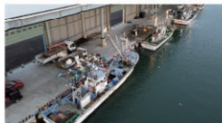
紋別港港町地区 水深4.0m西物揚場改良
